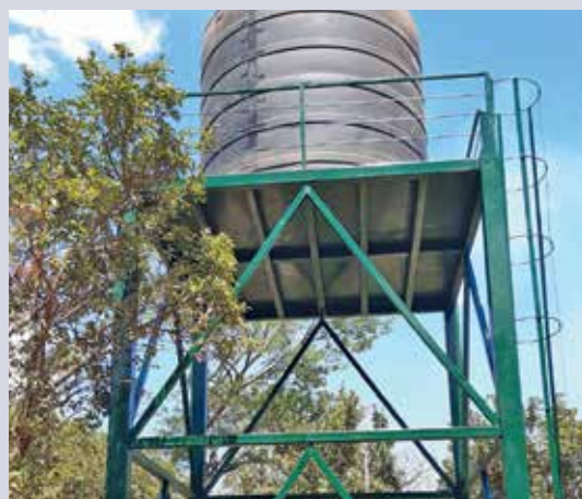
Dieser neu erstellte Wassertank wird dem zuständigen Wasserkomitee übergeben.
