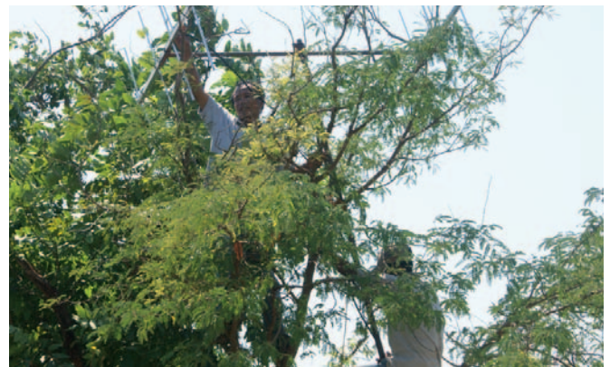
Mitarbeitende von Radio Alaminos montieren eine Radioantenne.
